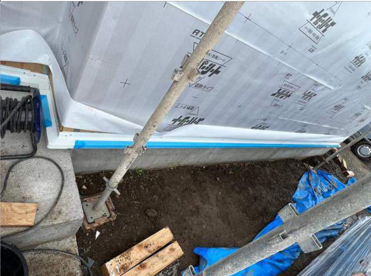
3-9口貫通部の防水措置を適切に処理する。一体成型品、または防水テープ処置
