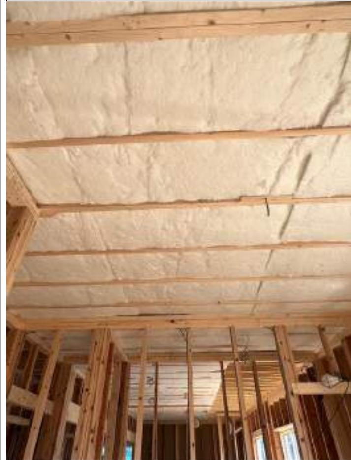
2-3口断熱材は隙間・欠損・施工不良がないように施工する。断熱材は配管部分に隙間ができないように気を付ける。
