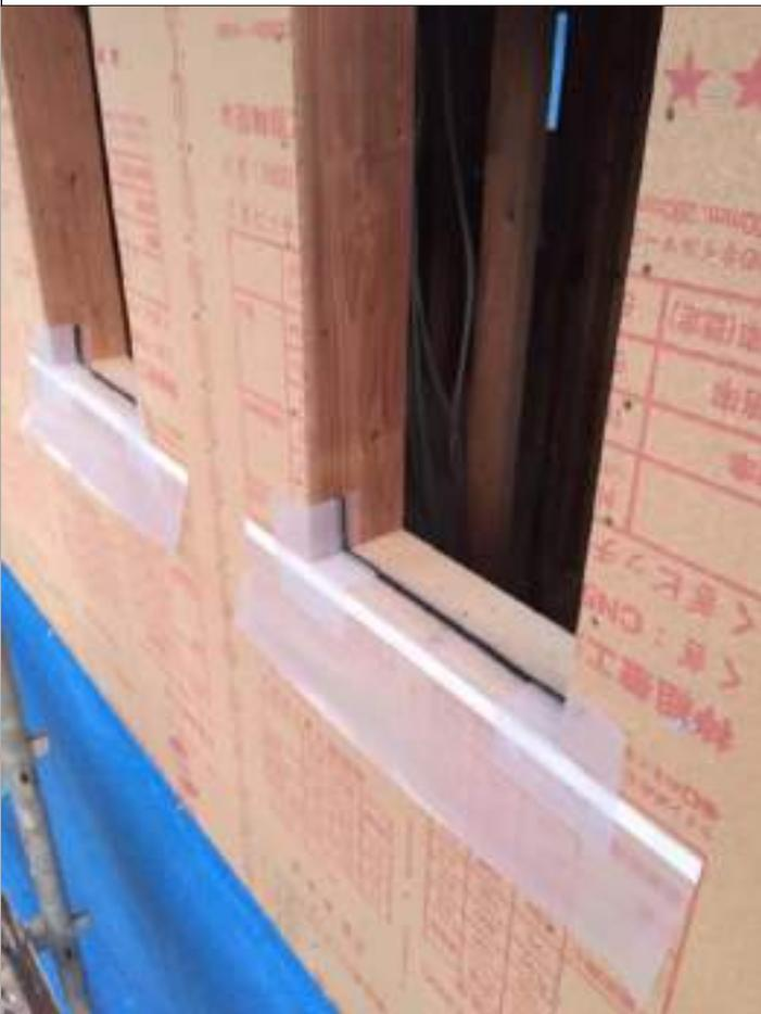
3-2口両面防水テープを用いて、サッシくぎ打ちフィンの根元を十分に覆い、縦・
