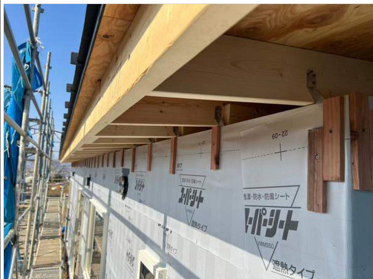
3-5口透湿防水シート（防水紙）の重ね代は、左右150mm、上下90mm以上取る。ステープルのピッチは100mmを目安とする。出入隅部は重ねつくりの施工をし、その際重ね代を150mm以上確保し、かつ重ね部分を乱にする。
