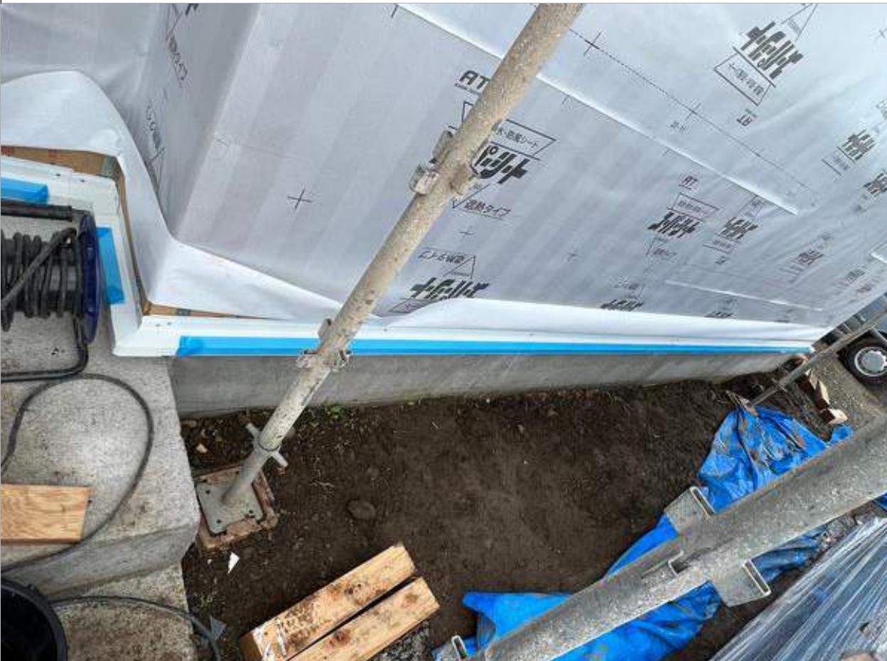
3-8口土台水切り・雨押さえに防水シートを端部に密着させる。
