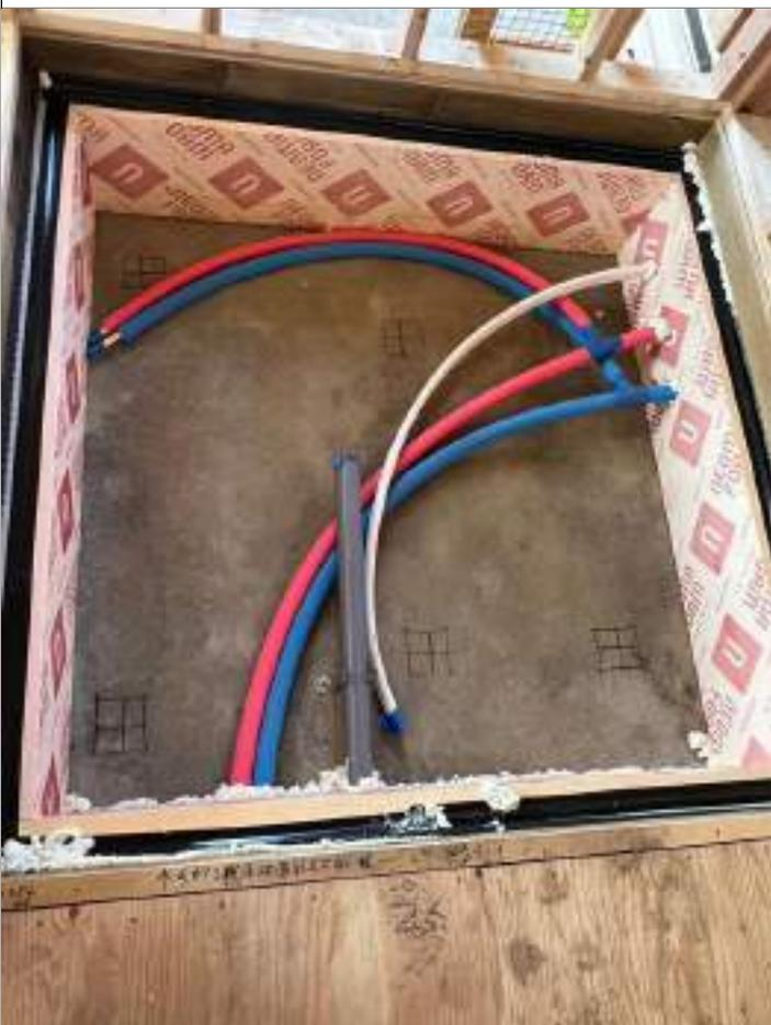
2-5口防湿層（気密シート）は幅広の長尺シートを用い、連続させ、隙間のないように施工する。継ぎ目は下地材のある所で30mm以上重ね合わせる。
