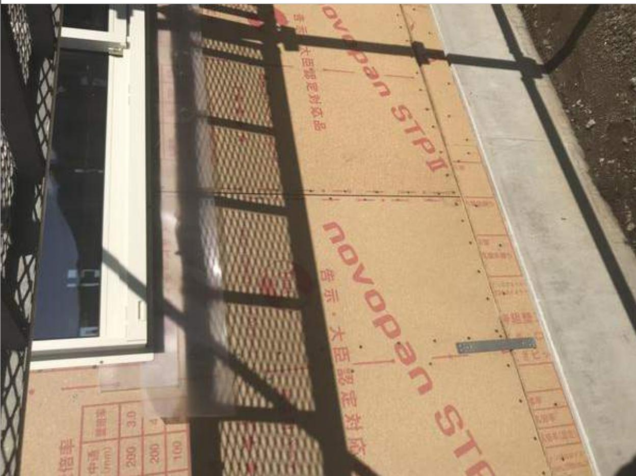
3-4口軒天井と外壁の取り合い部の防水紙張り上げは目安として、軒天井から100mm程度以上、又は小屋裏換気に支障がないところ（垂木下端など）まで張り上げる。
